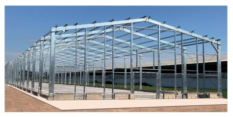
El cálculo estructural de los galpones INDIV® verifica el peso propio, las cargas de los componentes que se instalen en su interior y una velocidad de viento de hasta 120 km/h.
