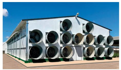
Construidos en vigas cajón de perfiles C conformados galvanizados.
